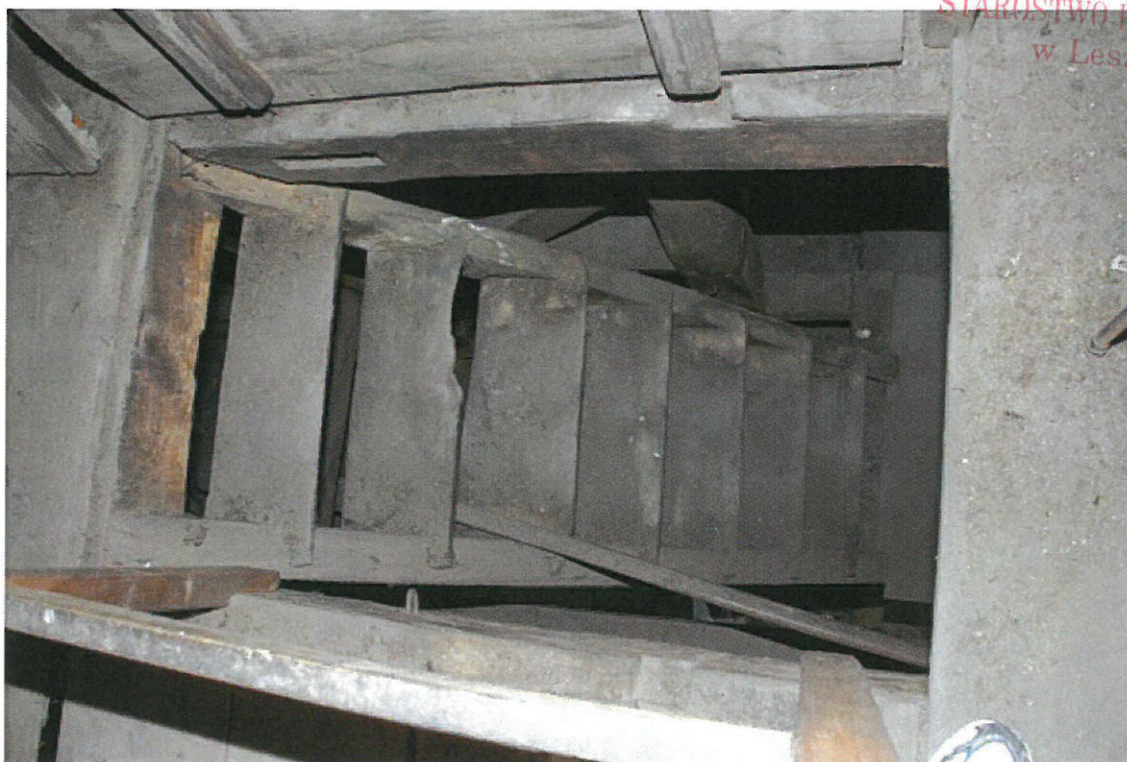
SCHODY NA WIEŻĘ DO MECHANIZMU ZEGARA DO WYMIANY
