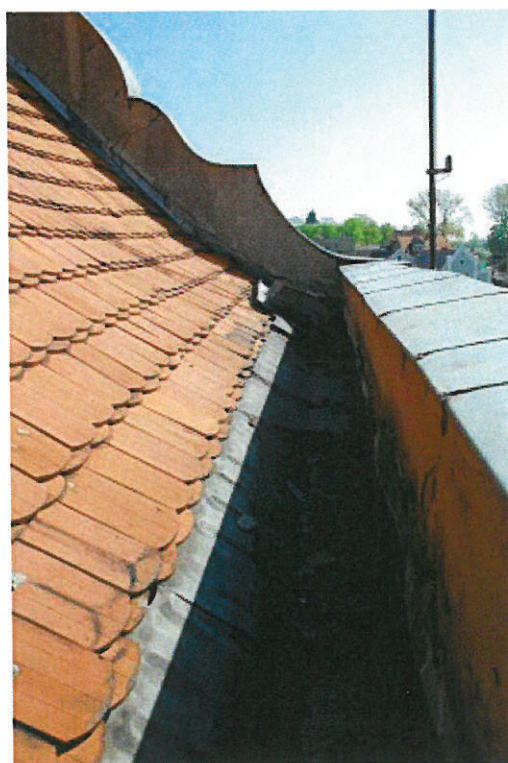
KORYTO DACHOWE DO WYMIANY
