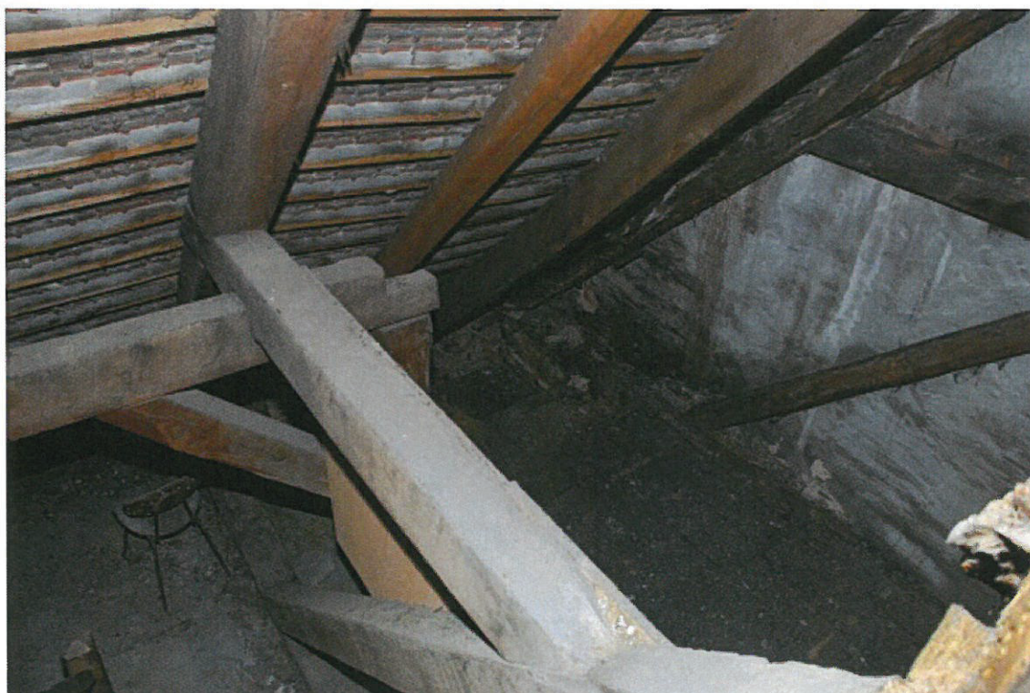
FRAGMENT ZAPADNIĘTEGO DACHU DO WZMOCNIENIA I WYPOZIOMOWANIA
