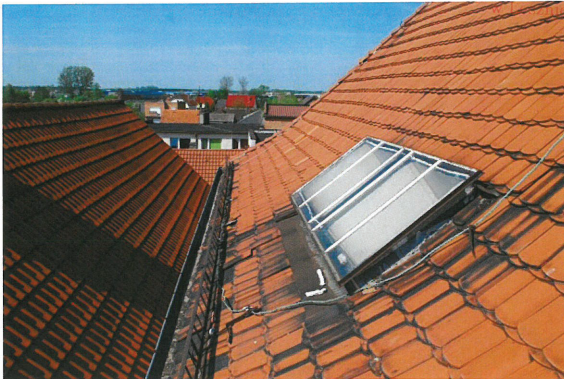
OKNO ŚWIETLIKOWE DO WYMIANY
